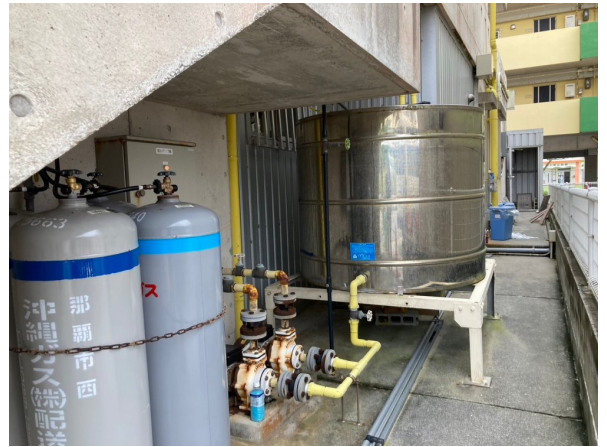
5.受水槽フェンスまわり
