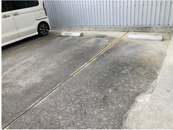
1. 駐車場・駐輪場
